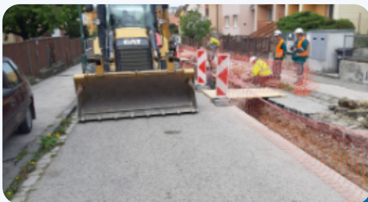
Výmena potrubí na Zlatohorskej ulici
