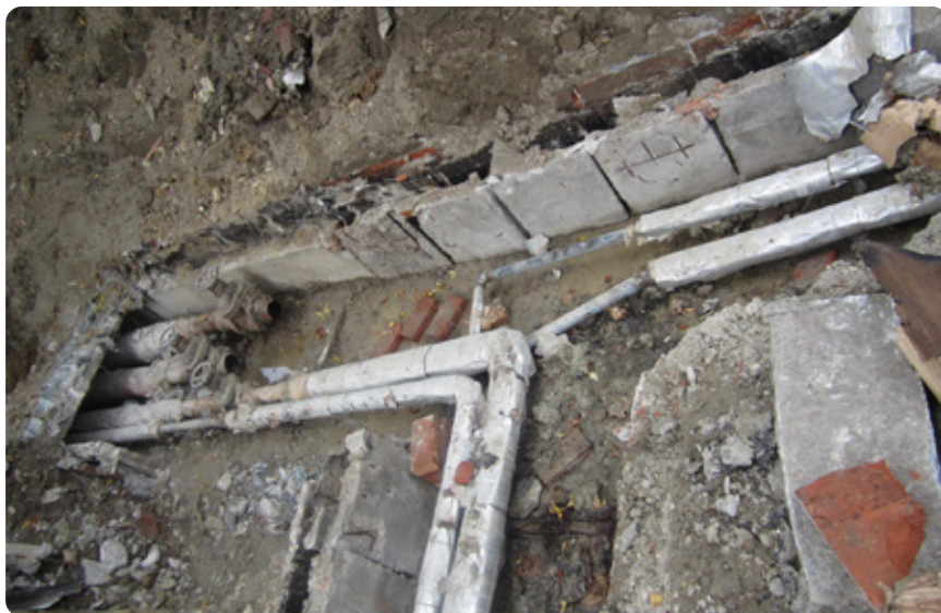
Takto vyzerajú rozvody po odokrytí kanála.
