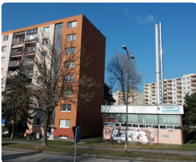
Kotolňa na Bakošovej ulici.
