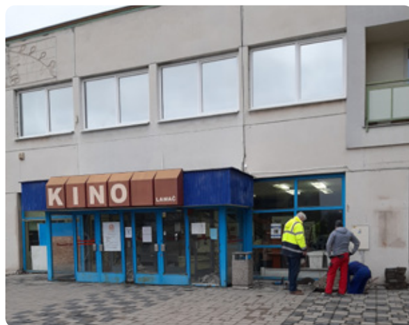
Práce na Kine Lamač sa začali v decembri.
